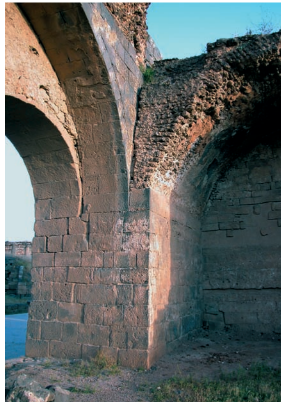
Les thermes du Centre, départs d'arcs du frigidarium (salle froide).
