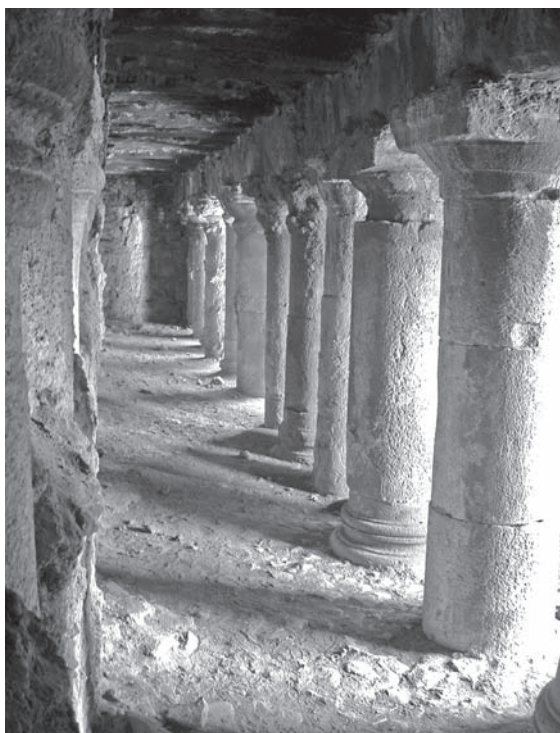
Les thermes du Centre : substructures de la citerne château d'eau nord-ouest (salle 31).
