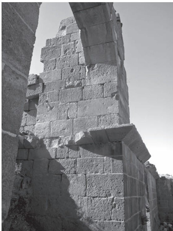
Les thermes du Centre : emplacement de la chaudière du caldarium nord-ouest (salle 10).
