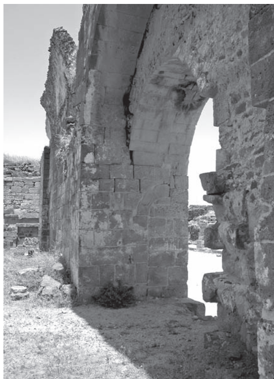
Les thermes du Centre : entrée du frigidarium (14), vestiges du premier état de l'édifice visibles dans le parement du passage.
